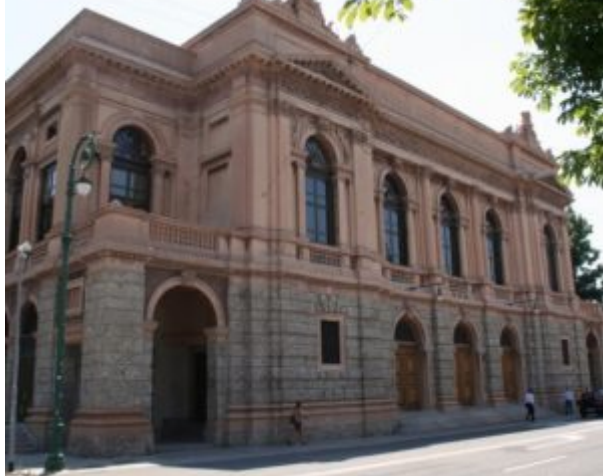
Nel 2017 il cantiere per la ristrutturazione del Teatro Donizetti: si tratta
