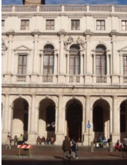
Lavori conclusi al Salone Furietti: un intervento che ha messo in sicurezza e restaurato
