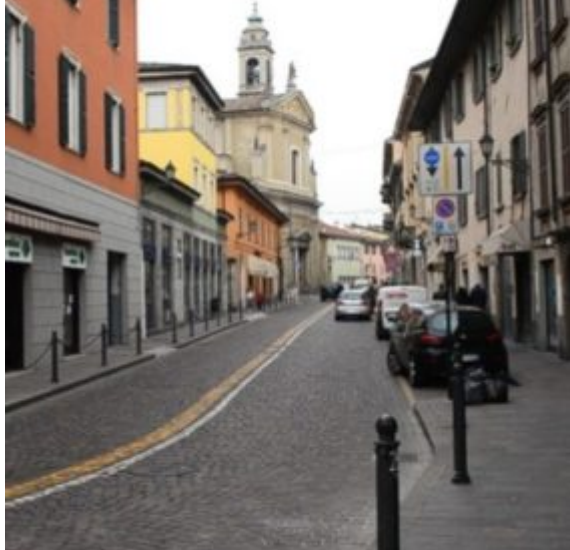
Partono i lavori di sistemazione della pavimentazione di Borgo Santa
